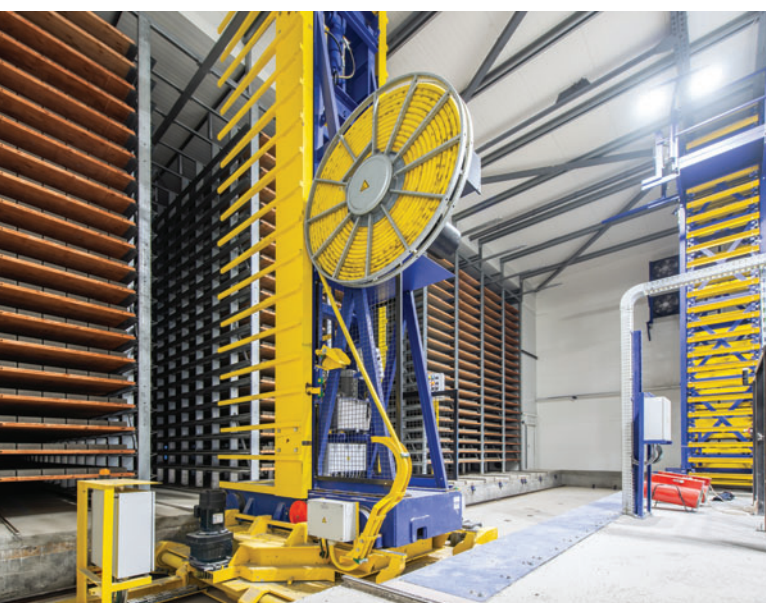
Deposito e prelievo dei blocchi in calcestruzzo nelle camere di maturazione
