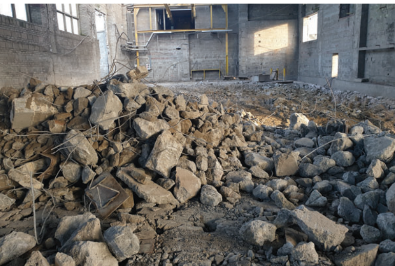
Les travaux de démolition avancent bien
