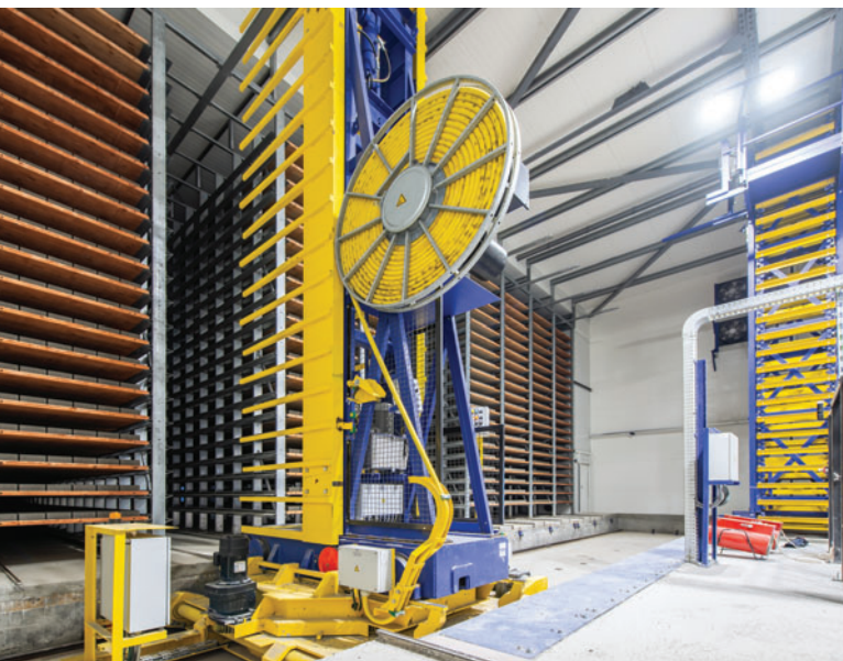
Introducción y extracción de los bloques de hormigón en las cámaras de curado
