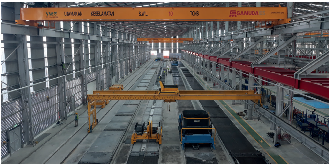
Echo hat vier jeweils 150 m lange und 2,4 m breite Produktionsbahnen und den Echo Slipformer S-Liner installiert.
