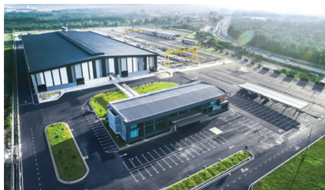
Gamuda hat das Werk erweitert und in eine Produktionslinie für Spannbetonelemente investiert.
