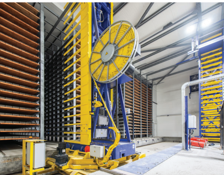
Ein- und Auslagern der Betonsteine in die Aushärtekammern
