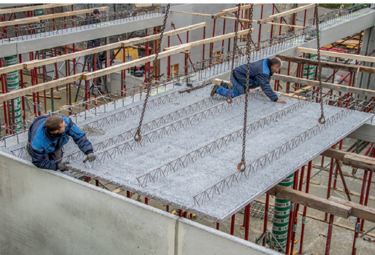
Nel moderno impianto a carosello di Ebawe Anlagentechnik, Jungwirth produce solai a lastre predalles e pareti doppie con e senza isolamento.
