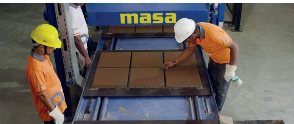
Controllo qualità manuale sulle lastre in calcestruzzo, appena prodotte
