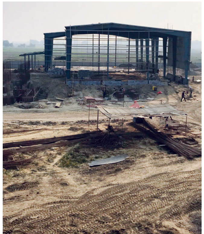
Construcción de la nueva planta de producción en Nawalparasi, Ramgram
