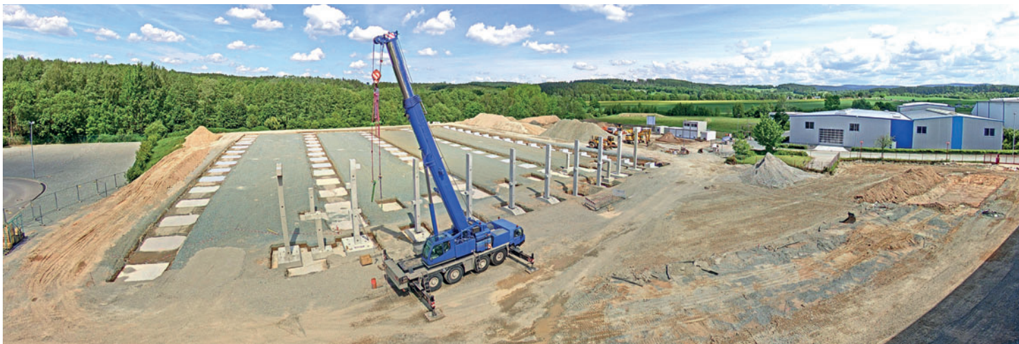
Kobra baut vier neue Fertigungshallen
