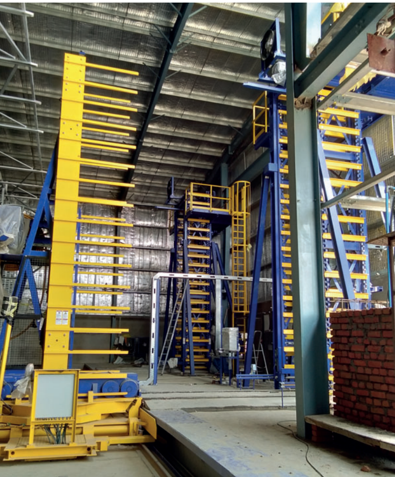
Montage von Hub-/Senkgerüst und Gabelwagen
