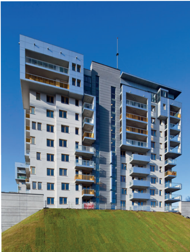
El uso de prefabricados de hormigón permitió reducir los tiempos de construcción, por ejemplo, en el proyecto del parque municipal de Osiedle.
