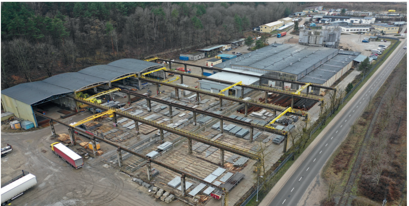
Nur 10 Arbeiter bedienen die neue EBAWE Palettenumlaufanlage in der Stadt Kolbudy.
