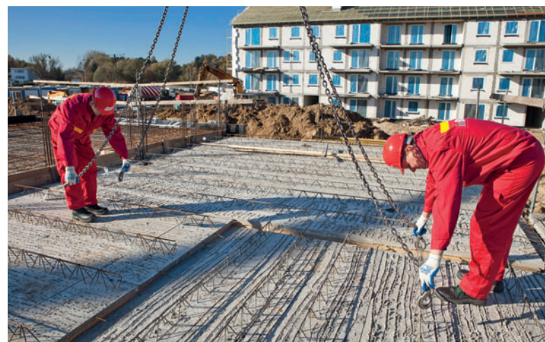
Elementdecken ermöglichen die schnelle und maßgeschneiderte Produktion und Installation von Betonfertigteildecken.
