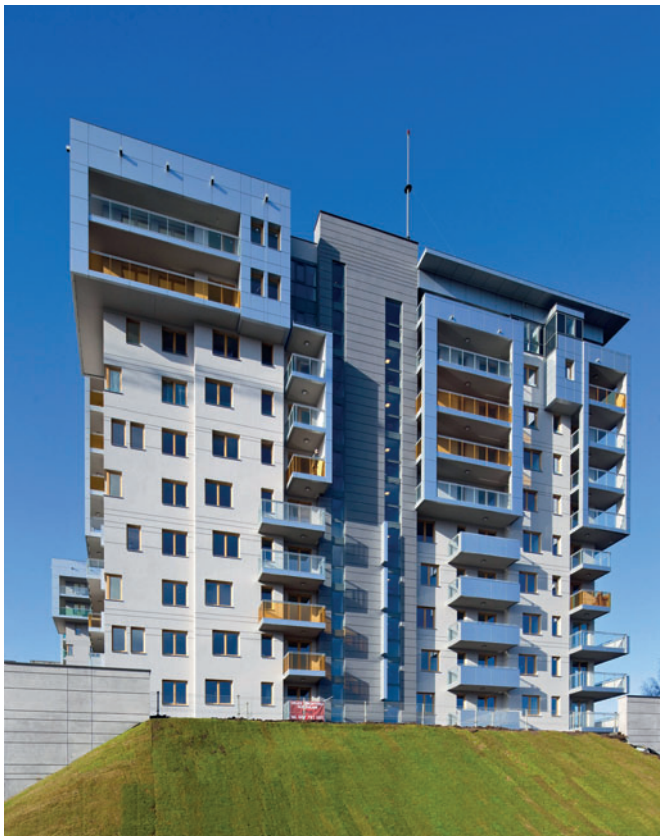
Durch den Einsatz von Betonfertigteilen wurden kürzere Bauzeiten ermöglicht, z. B. beim Projekt Stadtpark Osiedle.
