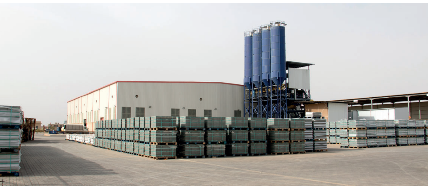
Uno sguardo al nuovo impianto di produzione nell'Arabia Saudita.
