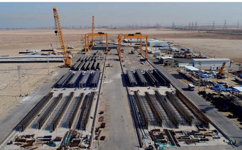
*9 ponti sono realizzati con elementi prefabbricati in calcestruzzo, prodotti con casseri della Tecnom in uno stabilimento di produzione locale.*
