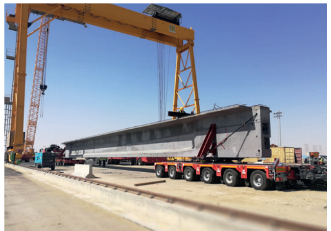
La situation idéale du centre de production à mi-chemin entre les deux chantiers les plus éloignés permet de minimiser les distances de transport à un rayon de 20 km max.
