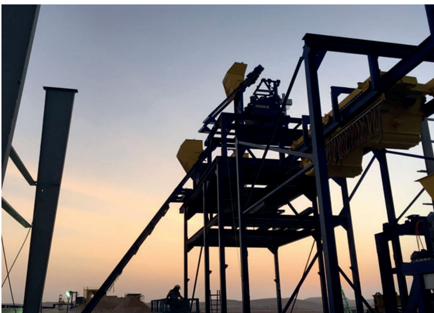
Le montage progresse bien : zone de malaxage avec double convoyeur à benne.
