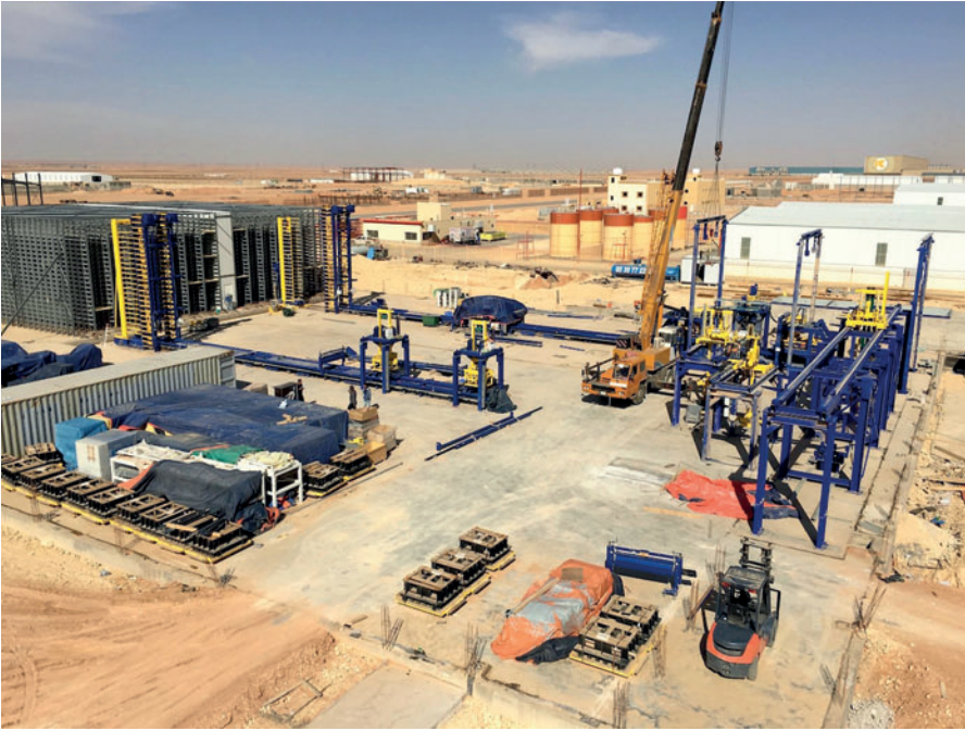
Phase de montage - l'espace de durcissement avec des rayonnages de HS Anlagentechnik ainsi que le chariot transbordeur Masa, l'ascenseur/descenseur et le chariot transbordeur tampon sont déjà mis en place.
