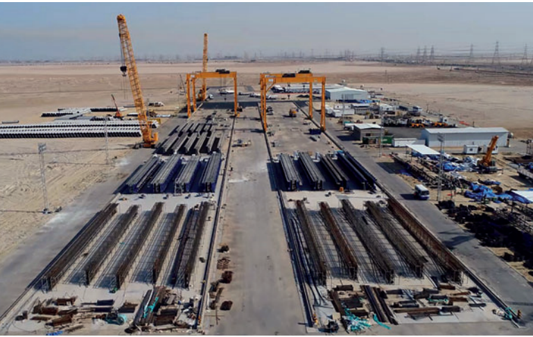
9 de los puentes se construyen con prefabricados de hormigón fabricados con moldes de Tecnomac en una planta de producción local.
