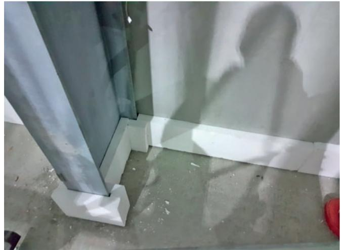
Isolierplatten sind eine geeignete Lösung für die Isolierung der Innenbereiche der Kammer gegen hereinziehende Kälte. Sie müssen allerdings vor dem Einbringen des Estrichs angebracht werden. Sämtliche Stützen der Stahlkonstruktion einer Halle müssen gegen den Betonboden isoliert werden. Stahlstützen sind sehr gute Wärmeleiter und haben großen Anteil an der Entstehung von Wärmebrücken.
