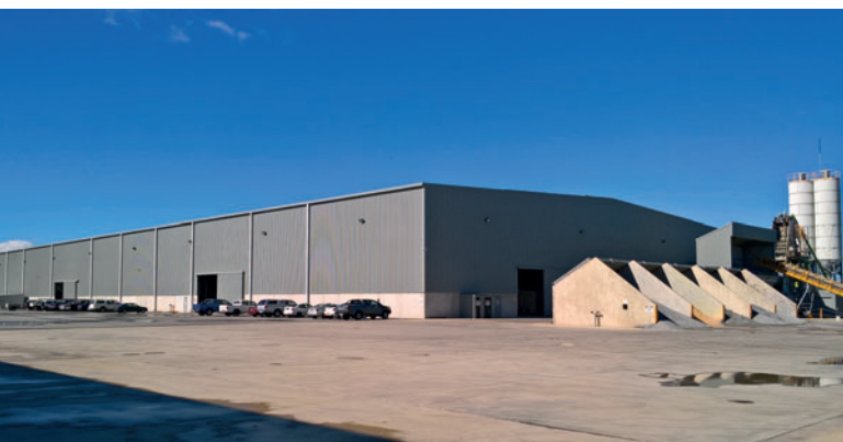
Dans son usine ultra moderne de Kwinana, BGC Precast fabrique des panneaux muraux architectoniques de haut de gamme sur mesure. (photo : BGC)
