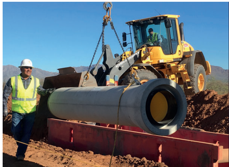
Pose de Tuyaux Perfect dans le comté de Pima, en Arizona, en 2017 : un grand nombre de tuyaux diamètre 400 posés en conditions réelles et mis en service
