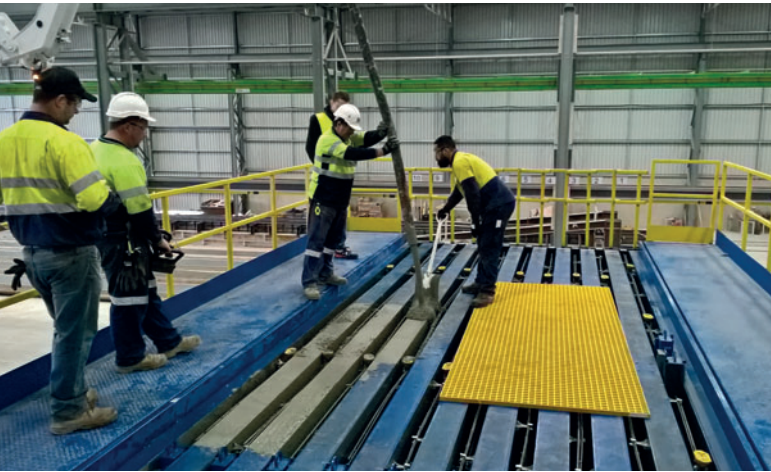
Los encofrados en batería para muros prefabricados aumentan la productividad en espacios limitados. BGC produce hasta 20 elementos de muro por ciclo.
