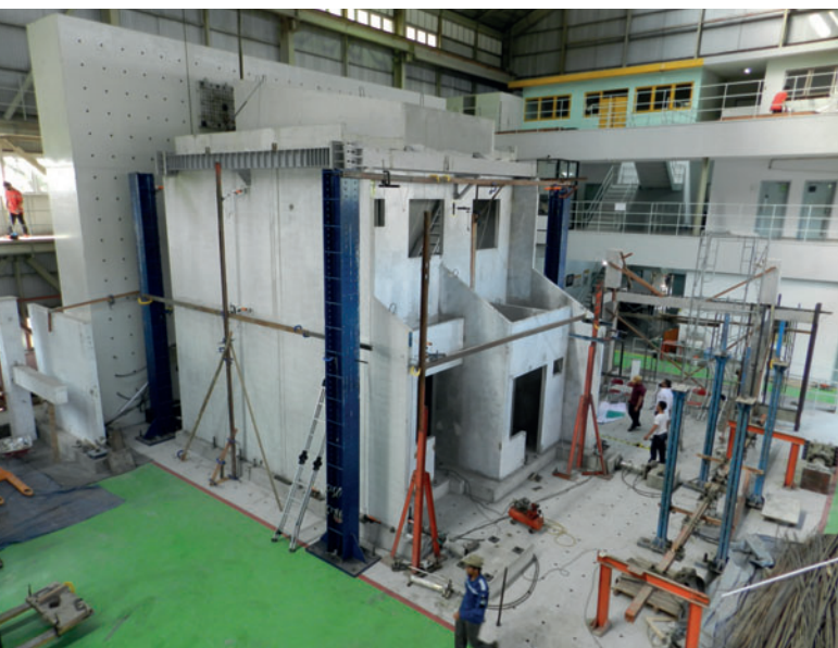
Первостепенной задачей для ведущего застройщика PT Modernland стало внедрение принципов сейсмостойкого строительства в свой проектировочный процесс и все реализуемые проекты
