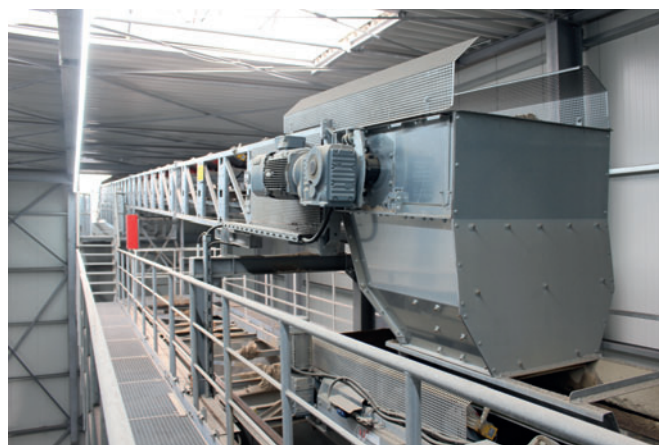
Gli aggregati per il calcestruzzo per lo strato di rivestimento vengono trasportati con un nuovo nastro trasportatore dal capannone accanto già esistente.
