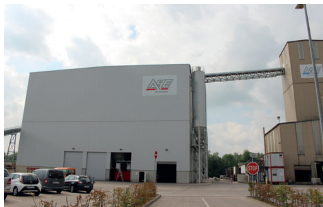
Gli aggregati per il calcestruzzo per lo strato di rivestimento vengono trasportati ai silos con un nastro trasportatore inclinato.
