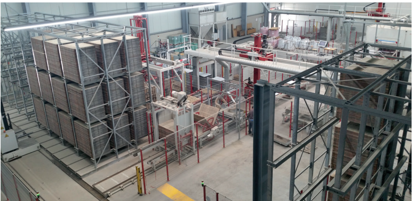
Panoramica dell'impianto, linea del secco con accumulo di pannelli
