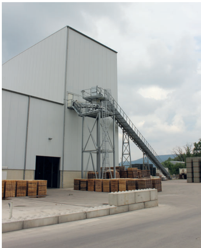
Les granulats pour le béton de parement sont acheminés jusqu'aux silos par un convoyeur incliné.
