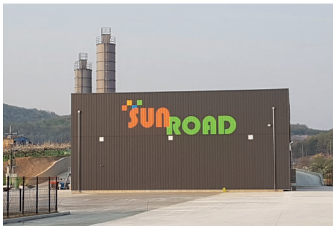
Новый завод компании Sunroad по выпуску мелкоштучных бетонных изделий
