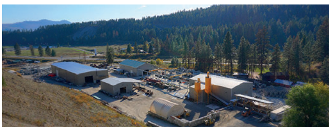
Vista dello stabilimento Leko Precast nella sede di Vernon, British Columbia, Canada
