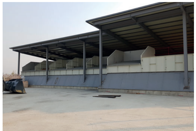
Vista de los silos de áridos
