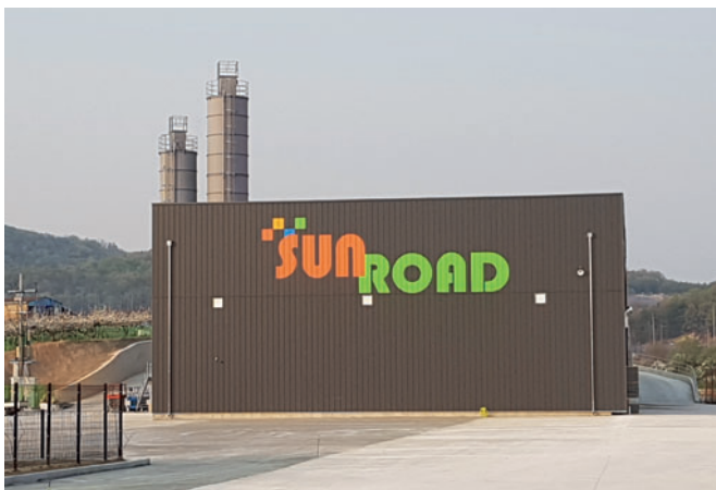
La nueva fábrica de bloques de hormigón de Sunroad
