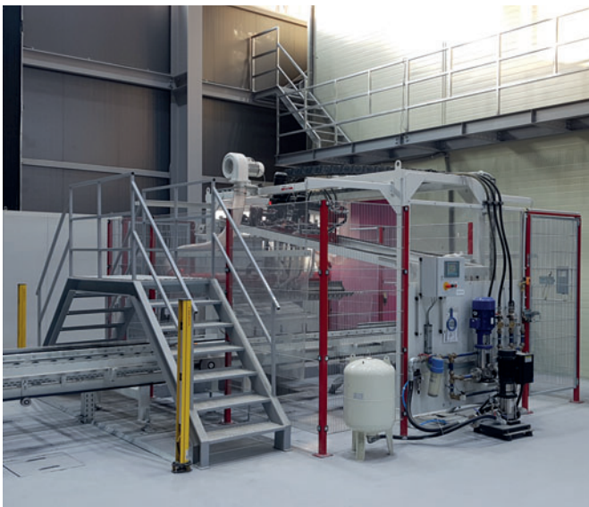
En el transporte del lado húmedo se ha montado un equipo de lavado doble.
