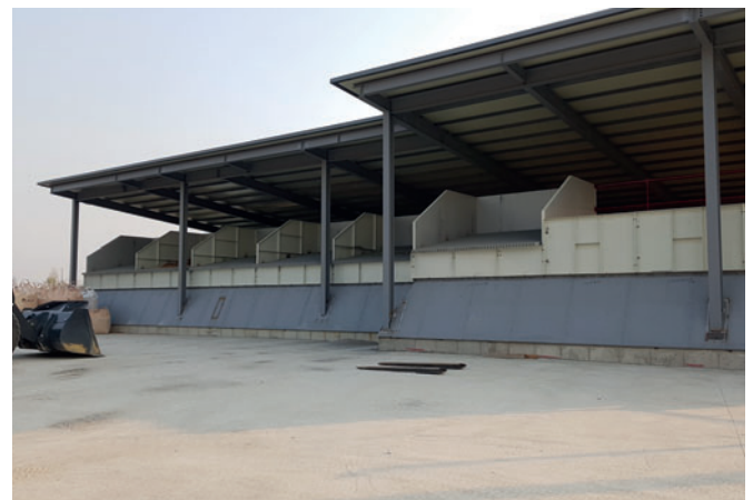
Blick auf die Gesteinskörnungssilos
