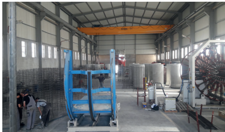
Цех по выпуску железобетонных труб
