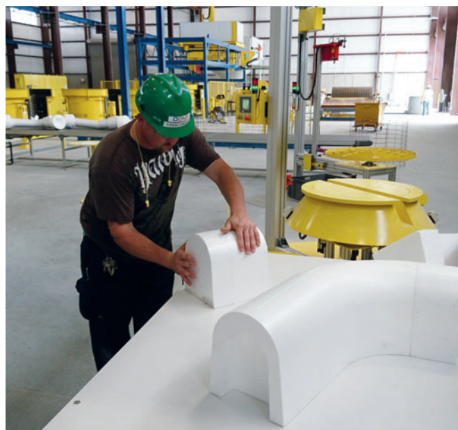
Gli oggetti formati tagliati con filo incandescente vengono assemblati semplicemente nelle conformazioni di canali di scolo richieste
