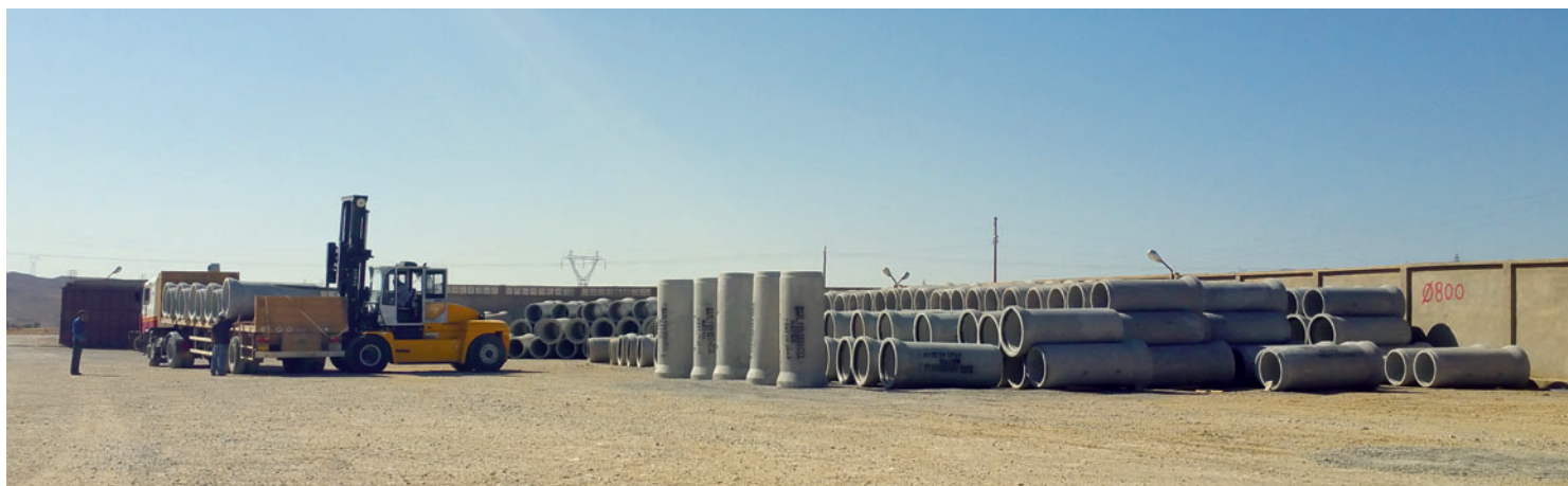
Vista dall'esterno area dello stabilimento con deposito
