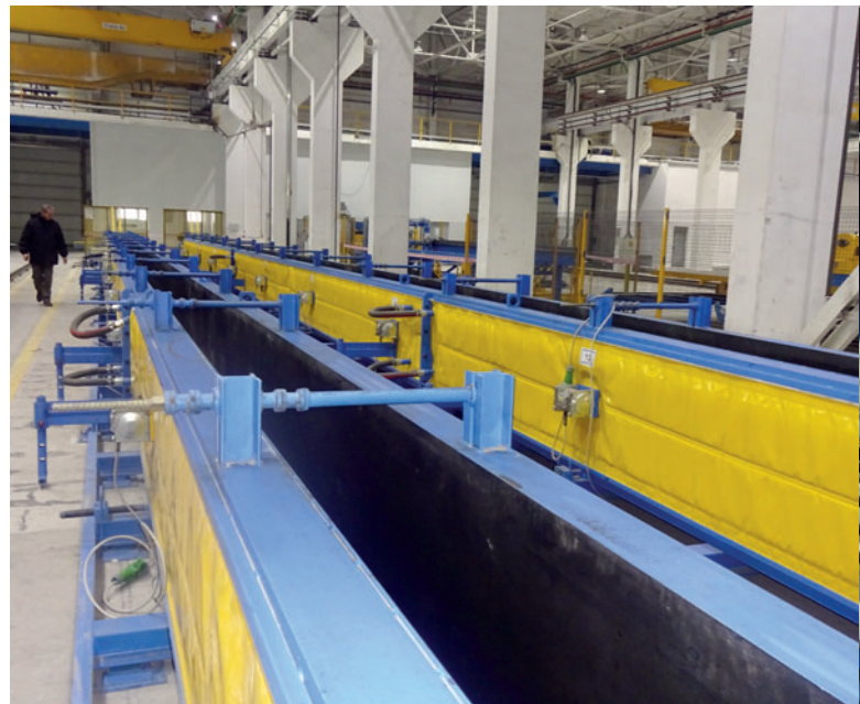
El especialista en encofrados Tecnom suministró también, además de los moldes en batería, moldes para la producción de pilares y vigas.
