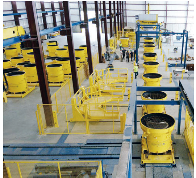
Das Fertigungssystem Perfect Forming Technology im CP&P Werk Ashland erlaubt eine der landesweit effizientesten Schachtunterteilmfertigungen.
