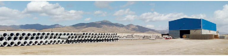
Außenbereich Lagerplatz mit Produktionshalle
