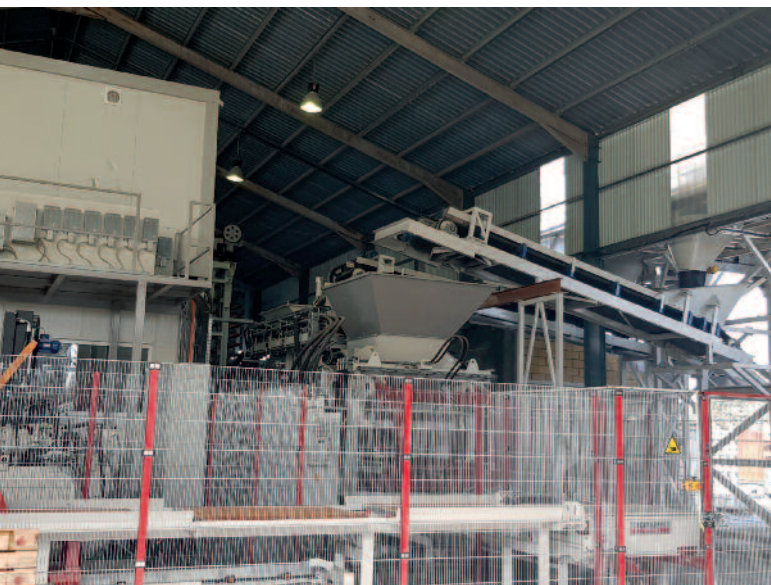
Podawanie podkładów produkcyjnych i mieszanki betonowej do wibroprasy RH1500.
