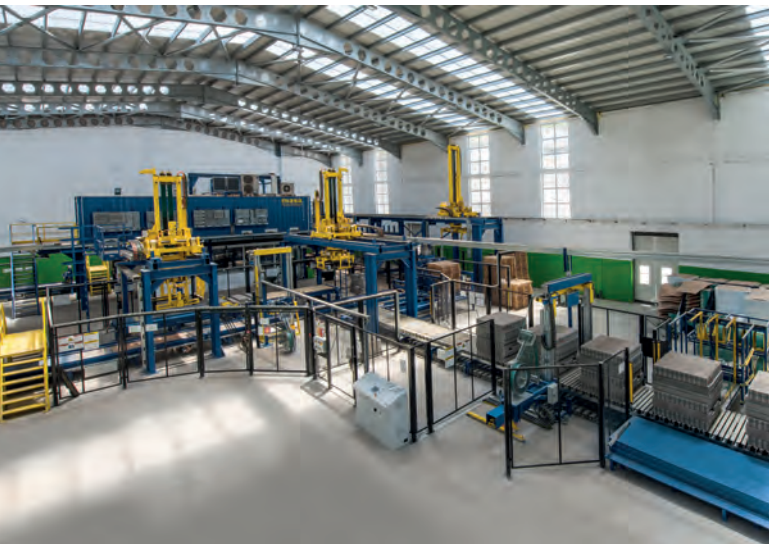
Рис. 2: Новая линия переформования: зона пакетирования оборудована высокоэффективным кубификатором Masa Cuboter
