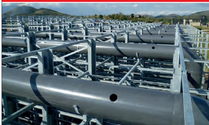
Система циркуляции воздуха для управления процессами твердения
