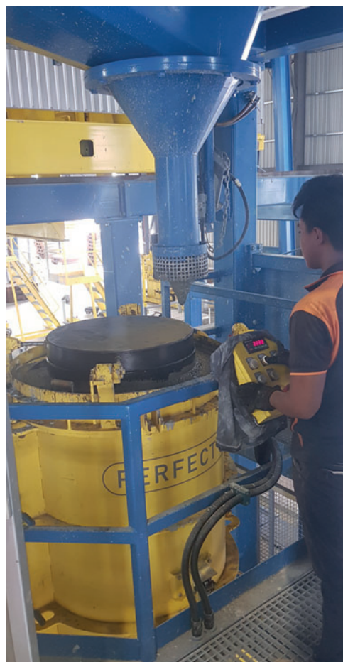
Riempimento degli stampi mediante calcestruzzo autocompattante (SCC)
