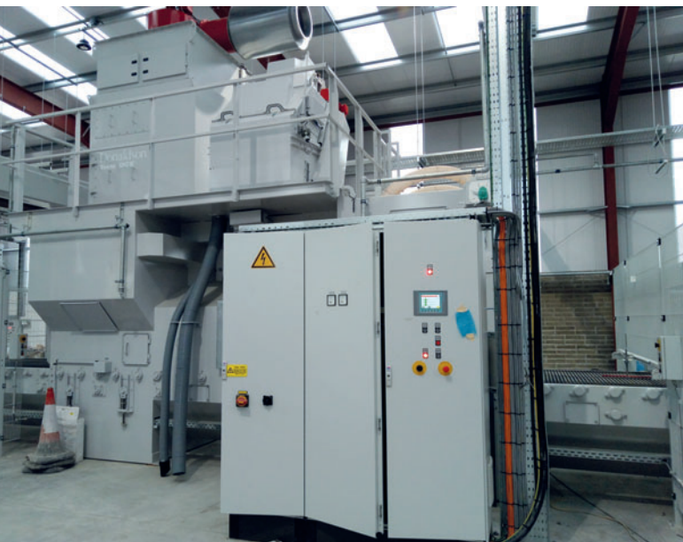
Dans la grenailleuse, les produits sont traités par couches avec un produit abrasif avec un espacement minimal de 600 mm par le biais de deux turbines à 18,5 kW
