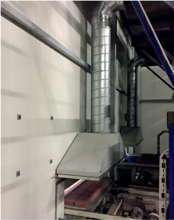
Toutes les ouvertures d'entrée et de sortie sont équipées de hottes d'évacuation dotées de ventilateurs intégrés, afin d'empêcher l'échappement de la chaleur et de l'humidité de la chambre dans la zone de production. Les hottes sont chauffées pour éviter la formation d'eau de condensation qui pourrait goutter sur les produits frais et les tacher.
