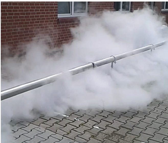
Распределительный паропровод с отверстиями или шланговым подключением для теплораздачи
