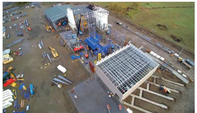
La nave de producción con una superficie de 9700 m 2 durante la fase de construcción
