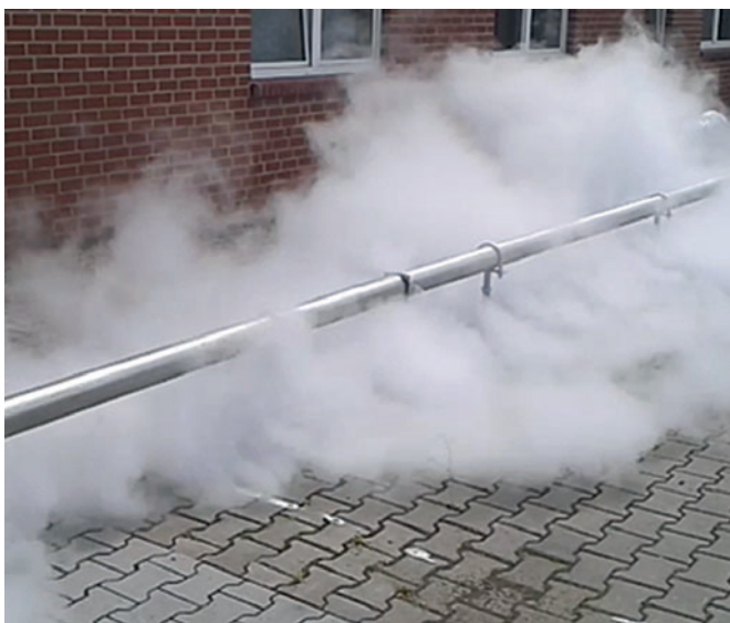
Conducto de distribución de vapor con perforaciones o conexiones de manguera para la distribución del calor.
