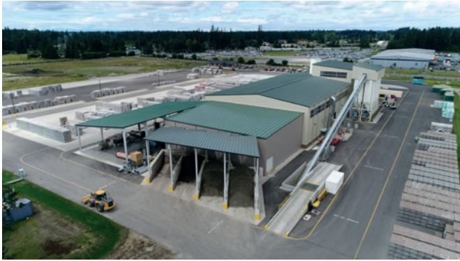
Neben den überdachten Lagerplätzen für Rohmaterialien im Außenbereich werden über eine Materialaufgabestation mit Steigband die acht Silos befüllt.
