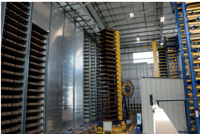
Der Gabelwagen mit Drehvorrichtung belädt die Aushärteregele.
