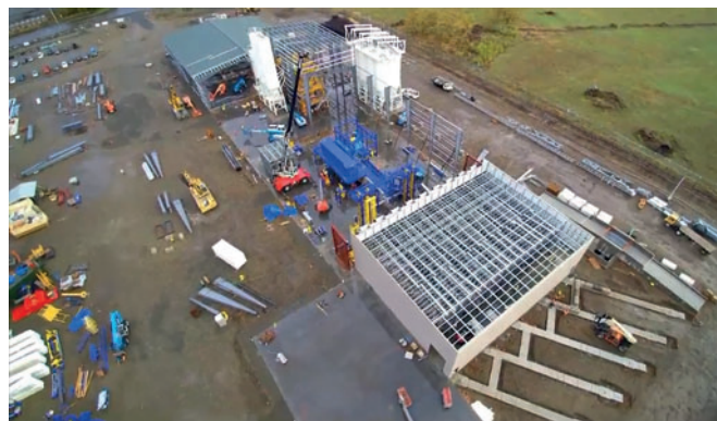
Die Produktionshalle mit einer Grundfläche von 9.700 m 2 in der Bauphase
