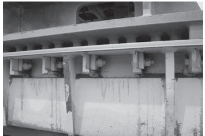
Рис. 3: Горизонтальное болтовое соединение
