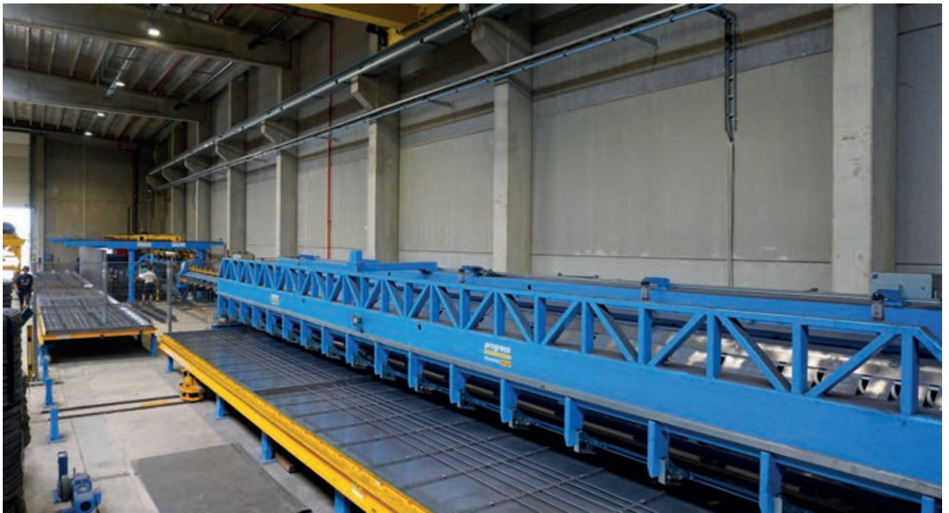
В целях автоматической укладки арматуры поддон перемещается в зону правильно-отрезного станка MSR
