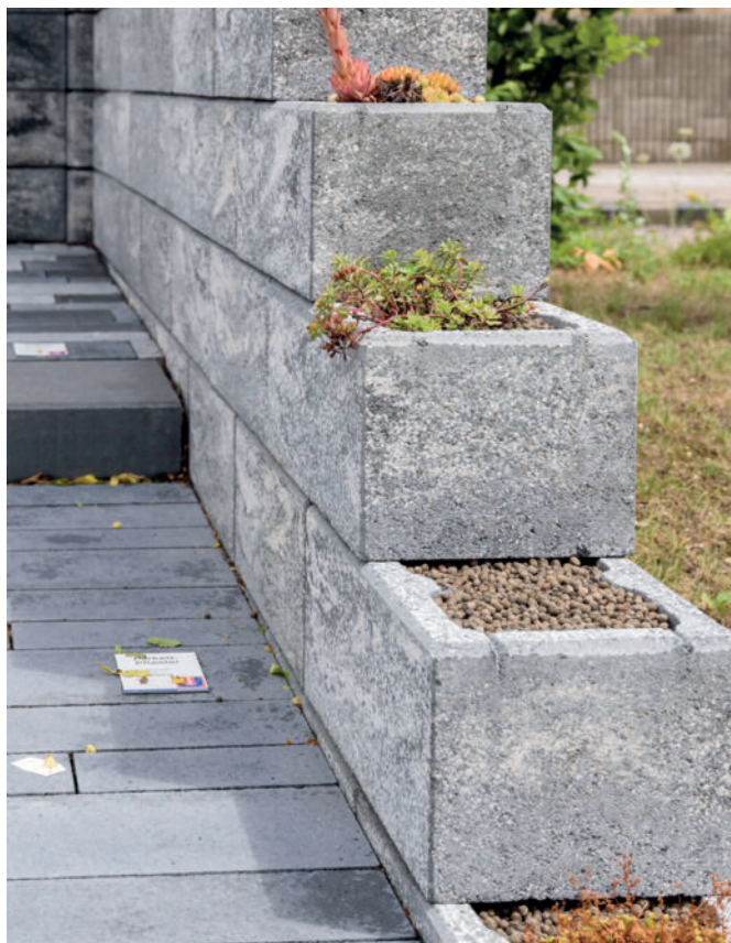
Mur Trendline z bloczków z betonu konstrukcyjnego barwionego w masie ma odcień antracytowo-biały.
