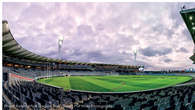
Per lo stadio Simonds di Geelong la Westkon Precast ha prodotto oltre 8500 m 2 di solai alveolari precompressi e 1250 m 2 di lastre per sedute.
