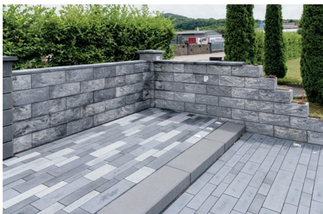
Il muro Trendline coniuga la versatilità statica di un blocco cassero con un aspetto ricercato.
