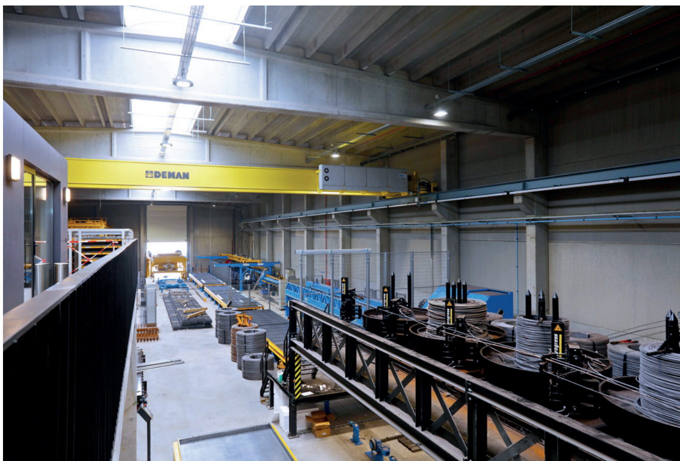
Il sistema a carosello è stato installato in uno spazio molto ristretto e automatizza importanti operazioni.
